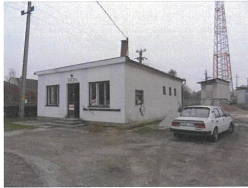
Keleti és északi homlokzat
